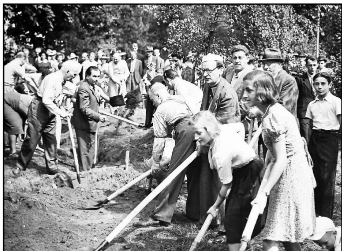
Kopanie rowów przeciwzołgowych
